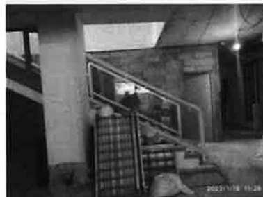
Obres adequació oficines SMAP 2 C/Fco. Rover
