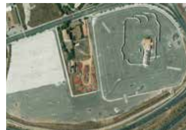
Recinte de Son Fusteret
